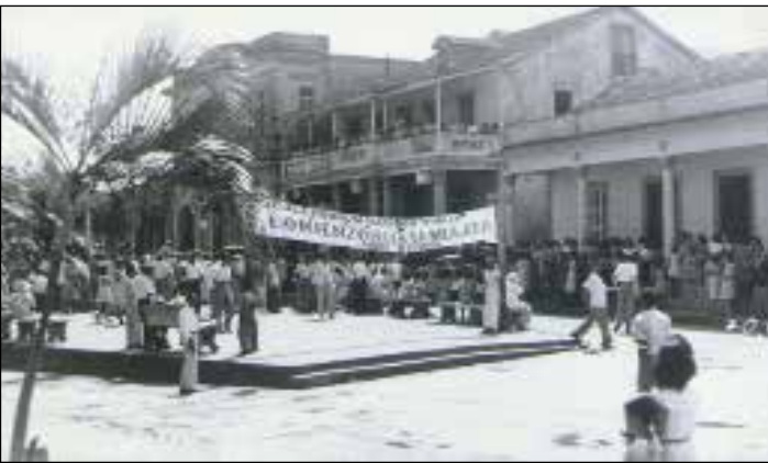
Estandarte en Baracoa pidiendo la construcción de la Vía Mulata
